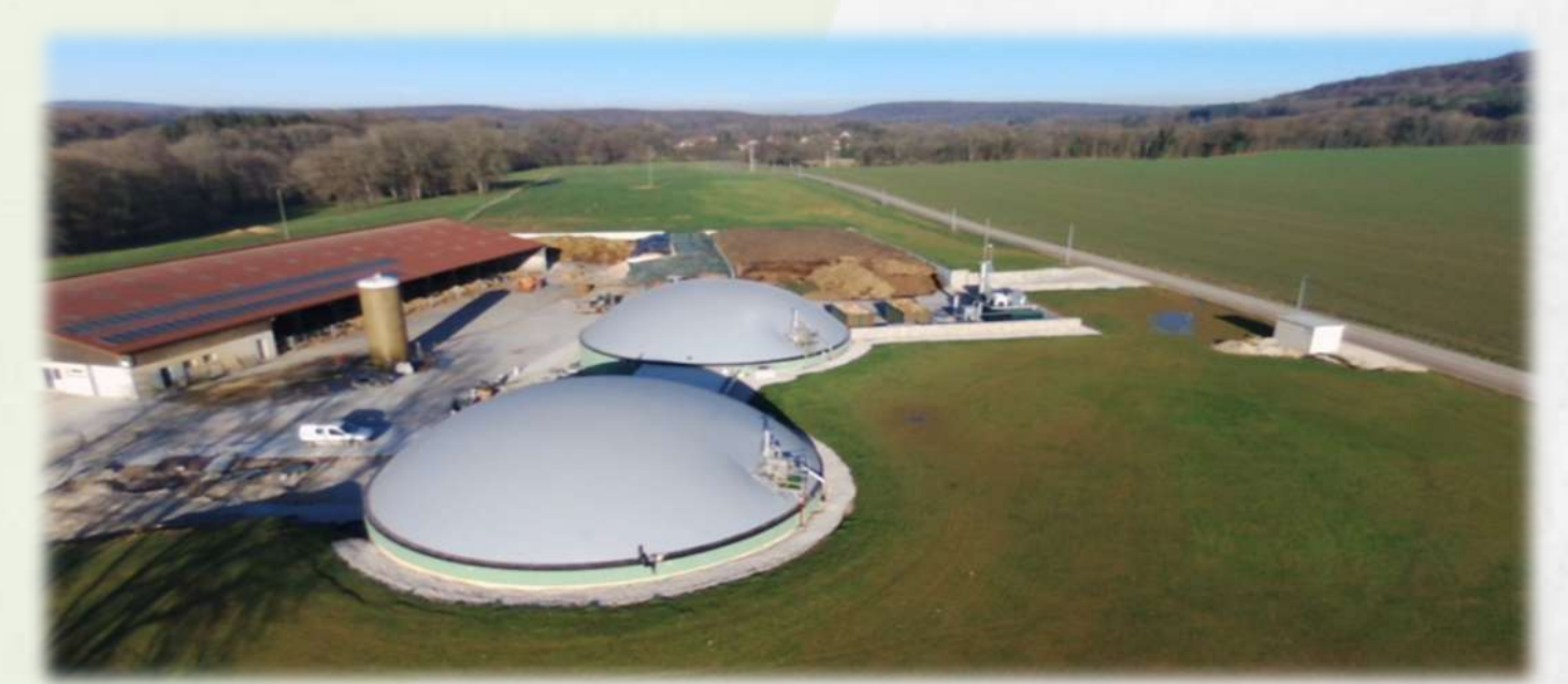
Unité de méthanisation voie liquide « infiniment mélangé » GAEC De La Foulrière
