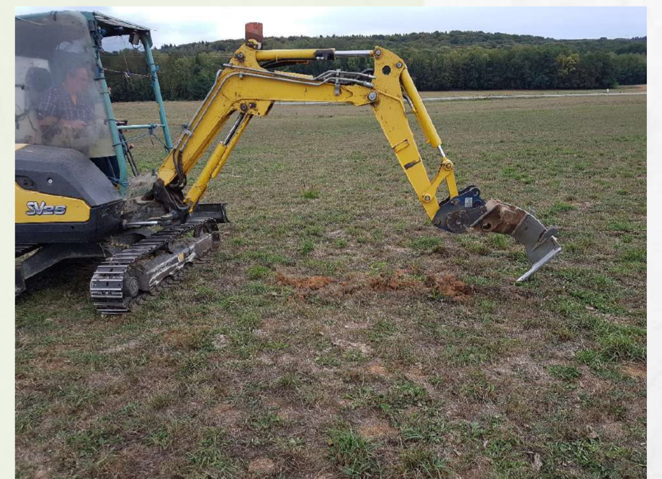
Préparation de sol à la mini-pelle CA 70 – D. JOLISSAINT
