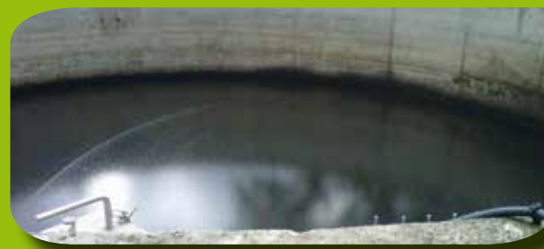
Boues de station d'épuration
